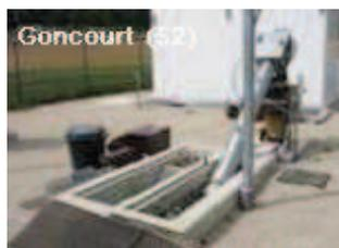
Le dégrillage peut être aménagé avec un système mécanique auquel on adjoint un compacteur ; cela limite les contraintes d'exploitation, réduit les nuisances et préserve la propreté.
