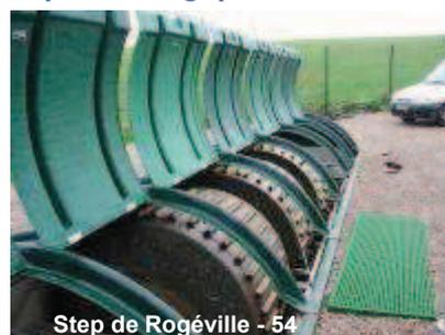
Il est nécessaire d'évaluer correctement le dimensionnement de la surface des disques pour assurer la pérennité du traitement.
