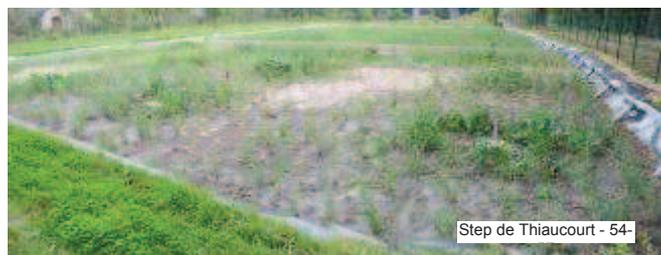
Les dépôts qui s'accumulent à la surface amoindrissent la perméabilité. Ils améliorent naturellement la répartition de l'effluent.
