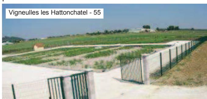
La caractéristique principale de ce type d'épuration réside dans le fait que les filtres du premier étage de traitement, dont le massif actif est constitué de graviers fins, peuvent être alimentés directement avec les eaux usées brutes dégrillées (sans décantation préalable). Cela évite à la commune de gérer les boues primaires qui présentent une stabilisation imparfaite.
