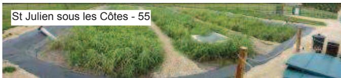
Si la déclivité des lieux le permet, les filtres plantés de roseaux peuvent être alimentés entièrement de façon gravitaire à l'aide de siphons auto-amorçant adaptés tant à la nature des eaux usées qu'au débit nécessaire pour obtenir une bonne répartition des eaux et des matières en suspension en surface des filtres du premier étage.
